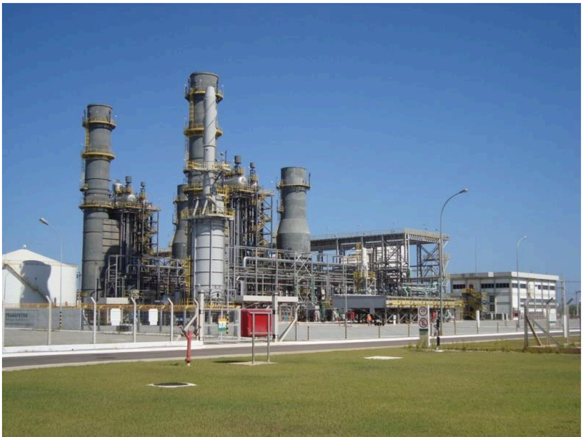
Figura 32 - Usina Termoeletrica Jesus Soares Pereira
