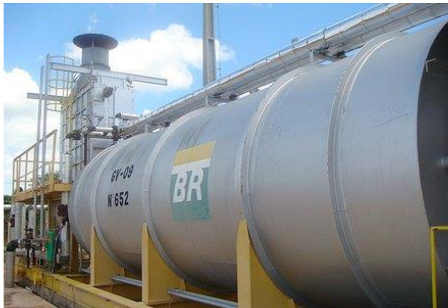
Figura 22- Gerador de Vapor
