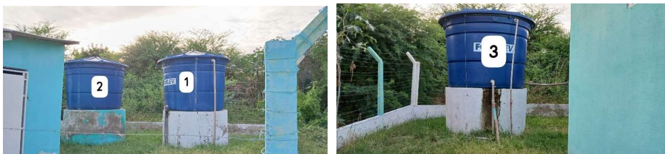
Figura 4- Caixas para o armazenamento da água bruta e água tratada
