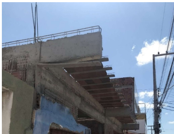
Figura 11 – Execução de marquise com laje nervurada de vigotas pré-moldadas.
