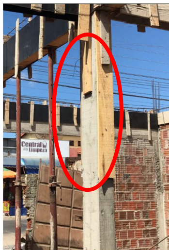
Figura 14 – Pilar de centro com concretagem utilizando vibrador.
