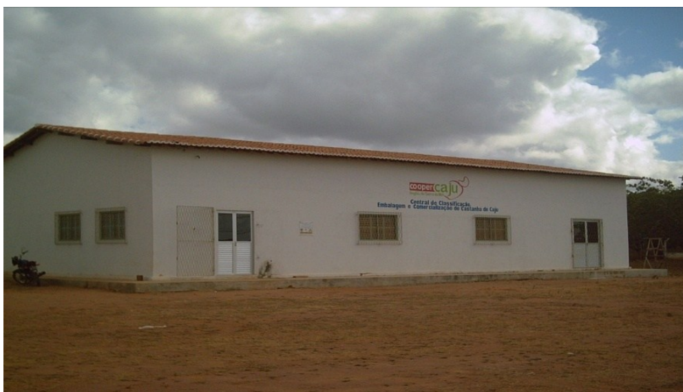
Figura 3. Casa central de classificação, embalagem e comercialização
