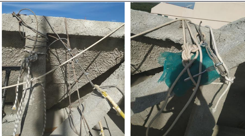
Figura 7. Fixação dos cabos de sustentação dos andaimes e dos trabalhadores no topo da construção. (Autoria Própria, 2018)
