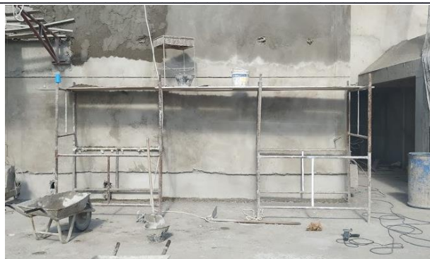
Figura 5. Andaime simplesmente apoiado da obra visitada. (Autoria Própria, 2018)
