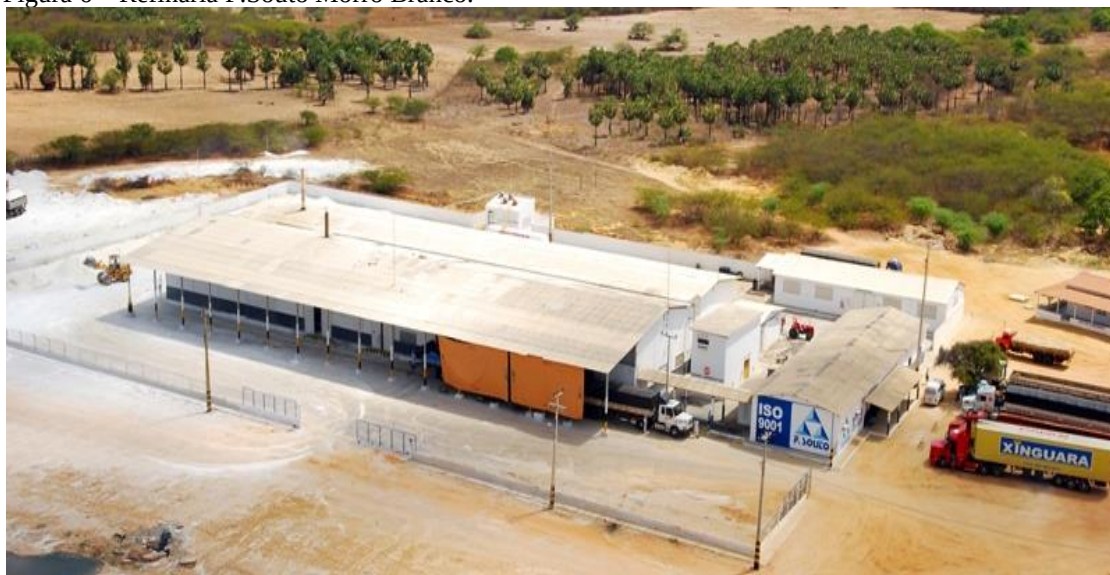
Figura 6 – Refinaria F.Souto Morro Branco.
