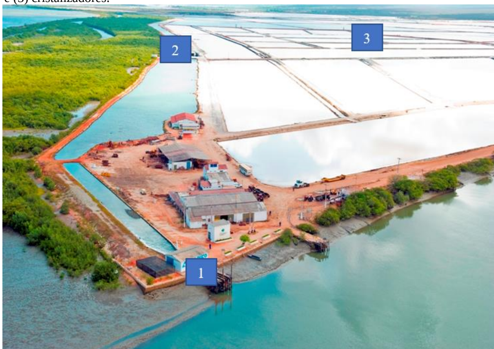
Figura 2 – Os principais setores da Salina Morro Branco: (1) casa das bombas, (2) evaporadores e (3) cristalizadores.
