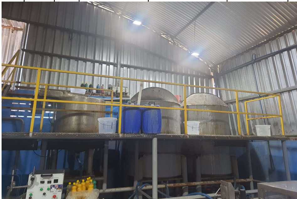
Figura 9 - Tanques de produção utilizados no processo de fabricação de sabão líquido.
