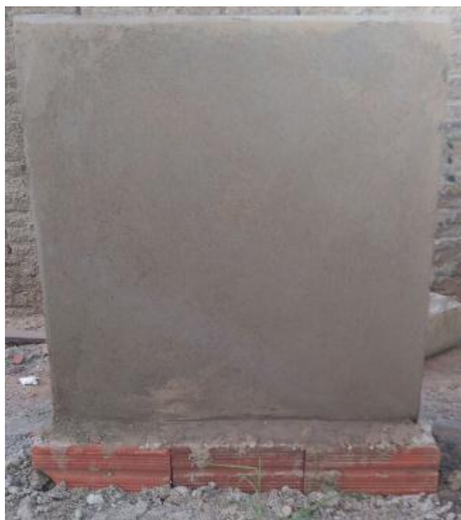
Figura 11 – Alvenaria depois de ser executado o reboco.
