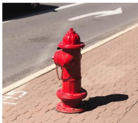
Figura 5 – Hidrante de coluna.
