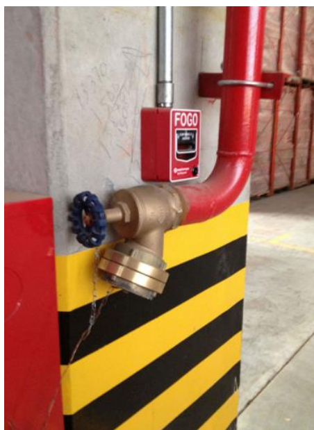
Figura 7 – Hidrante industrial.
