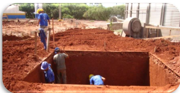
Figura 4. Escavação para tubulações.
