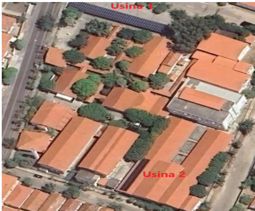
Figura 6 – Usinas fotovoltaicas instaladas no campus.
