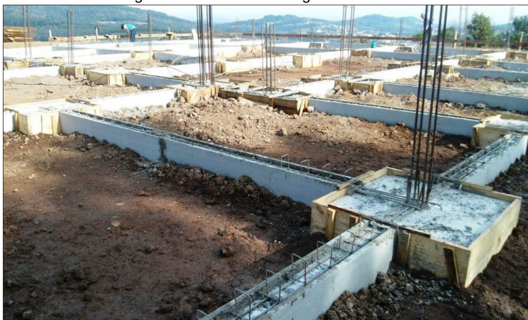
Figura 5.3 – Modelo de viga de baldrame
