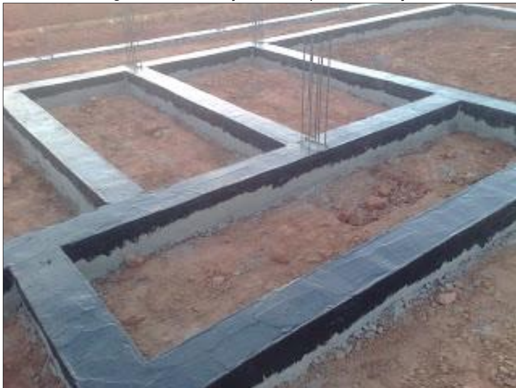
Figura 5.4 - Fundação com impermeabilização
