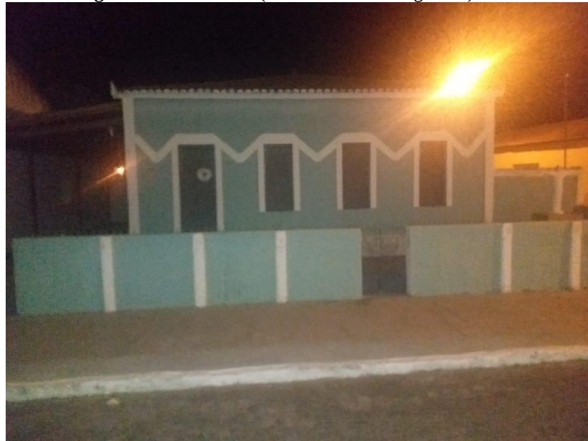
Figura 33: Fachada 03 (Levantamento Fotográfico)
