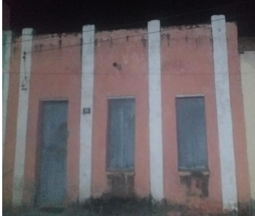
Figura 37: Fachada 07 (Levantamento Fotográfico)
