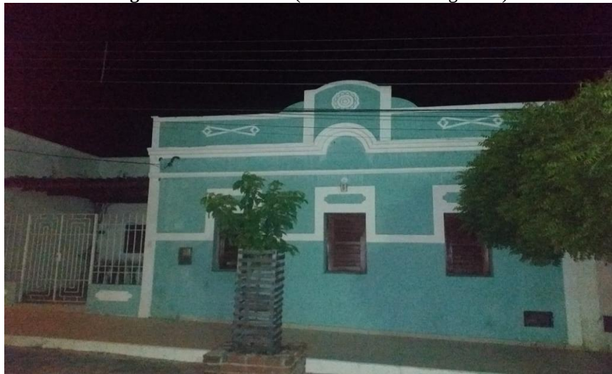
Figura 49: Fachada 15 (Levantamento Fotográfico)
