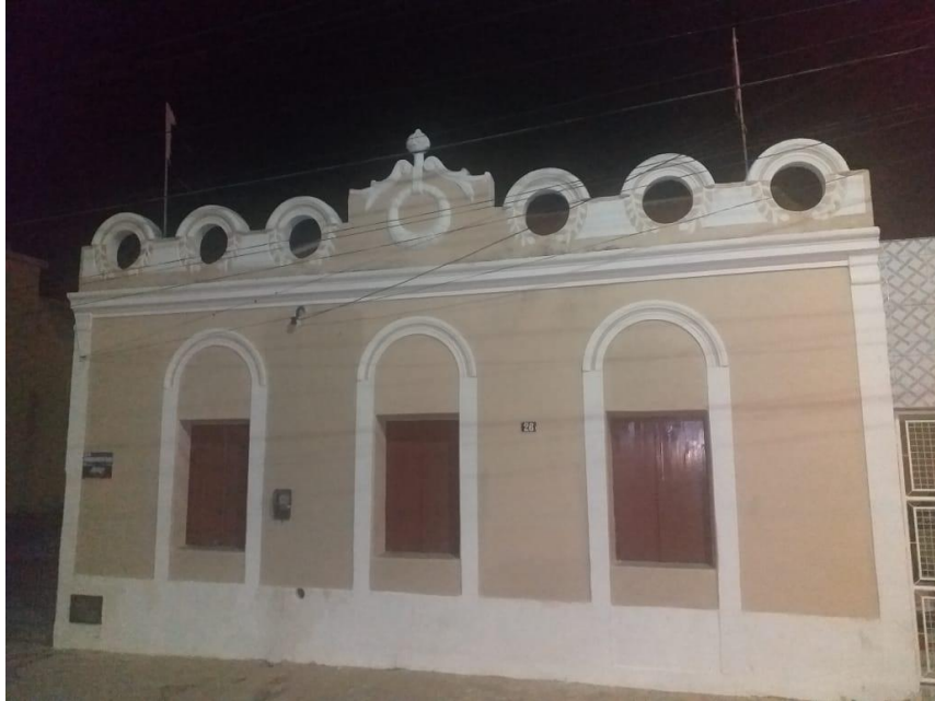
Figura 27: Fachada 05 (Levantamento Fotográfico)
