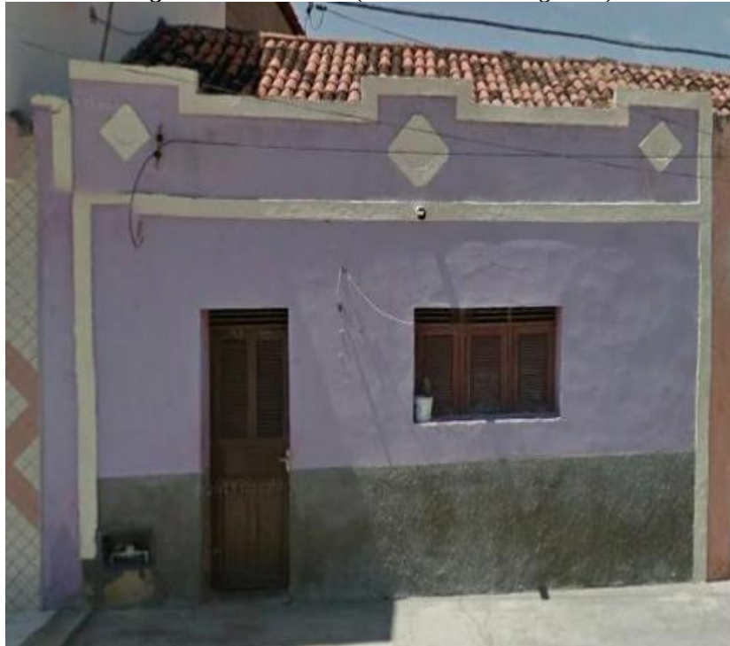
Figura 29: Fachada 08 (levantamento Fotográfico)
