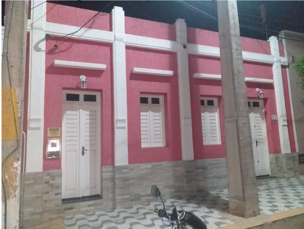
Figura 39: Fachada 19 (Levantamento Fotográfico)
