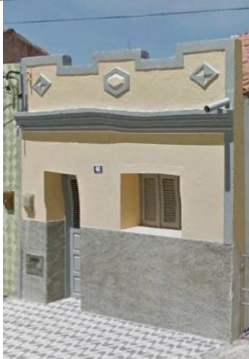
Figura 25: Fachada 04 (Levantamento Fotográfico)
