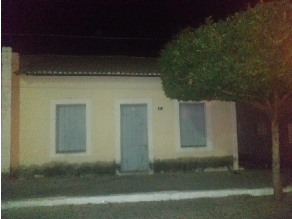
Figura 35: Fachada 23 (Levantamento Fotográfico)
