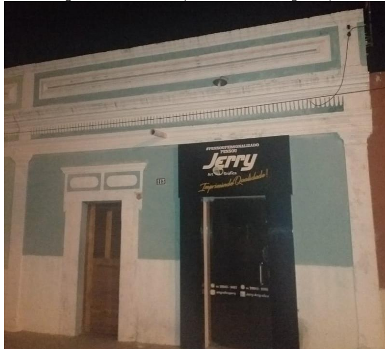
Figura 41: Fachada 11 (Levantamento Fotográfico)
