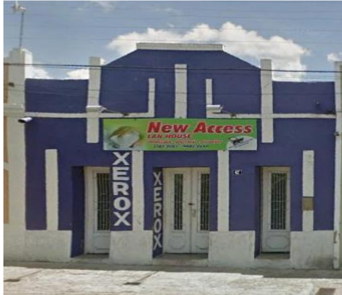
Figura 55: Fachada 14 (Levantamento Fotográfico)
