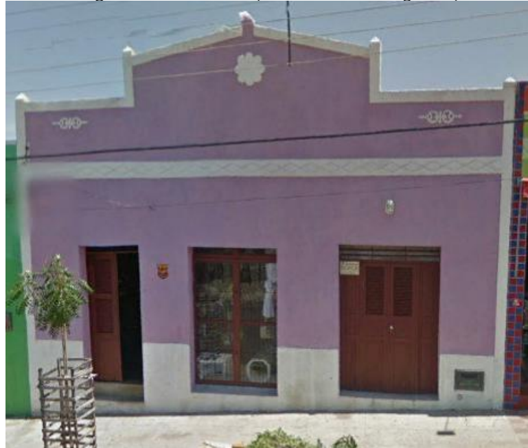
Figura 57: Fachada 18 (Levantamento Fotográfico)
