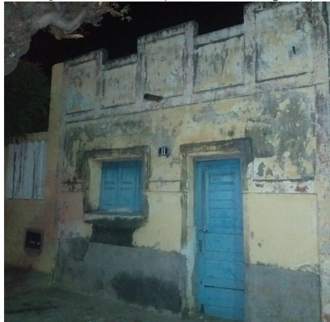
Figura 21: Fachada 01 (Levantamento Fotográfico)
