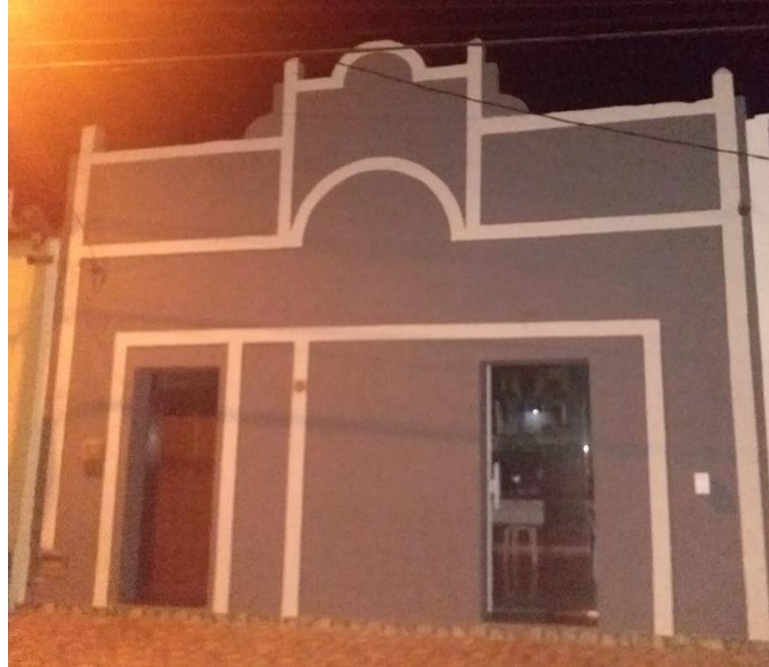
Figura 43: Fachada 16 (Levantamento Fotográfico)
