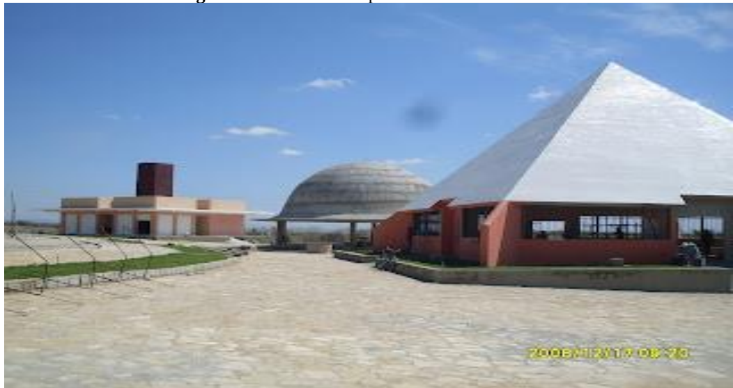
Figura 18: Parte do Complexo Concluído
