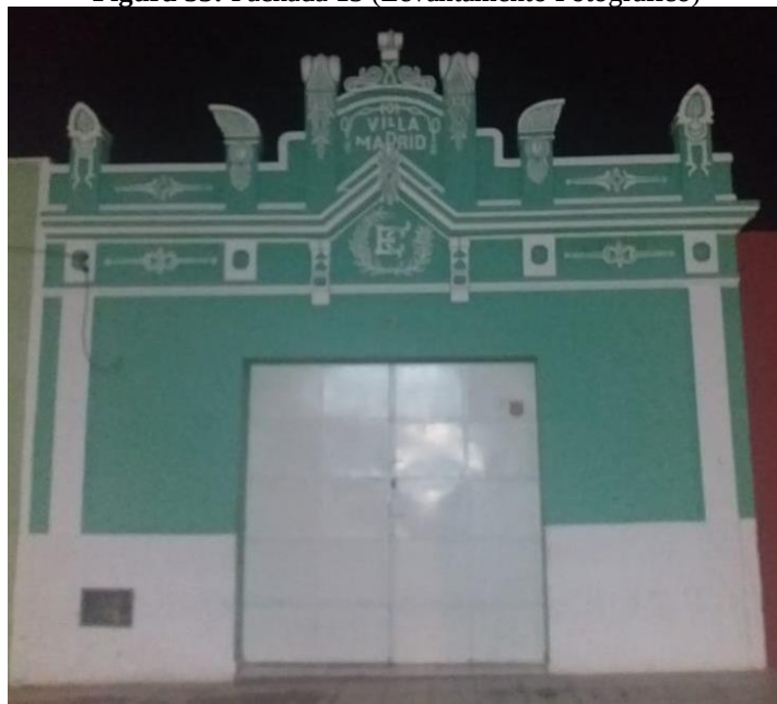
Figura 53: Fachada 13 (Levantamento Fotográfico)
