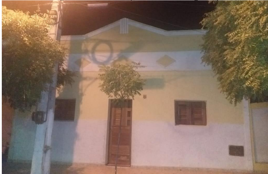
Figura 31: Fachada 23 (Levantamento Fotográfico)
