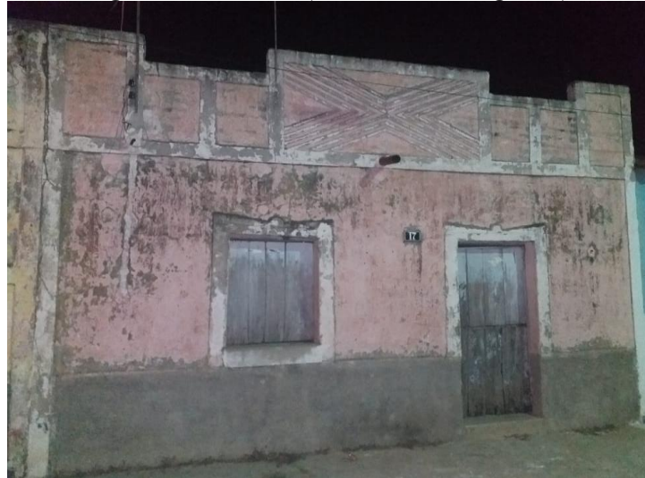
Figura 23: Fachada 2 (Levantamento fotográfico)
