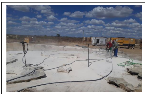
Figura 26: Perfurações dos furos
