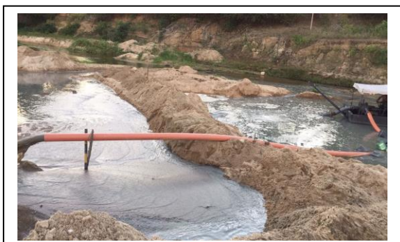
Figura 42: Dragagem de sucção
