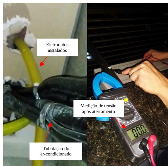
Fig. 5. Foto dos eletrodutos instalados e testagem da carcaça
