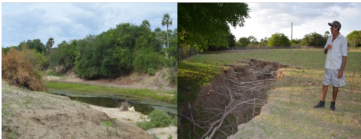
ILUSTRAÇÃO 11 – Assoreamento do Rio Angicos e erosão do solo na comunidade Olho D'Água Velho, Mossoró-RN, beneficiados pela Chamada Pública SAF/ATER nº 010/2012. Fonte: Acervo do autor
