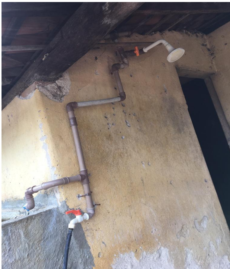
Figura 10 - Saídas de água não convencionais no exterior da residência.
