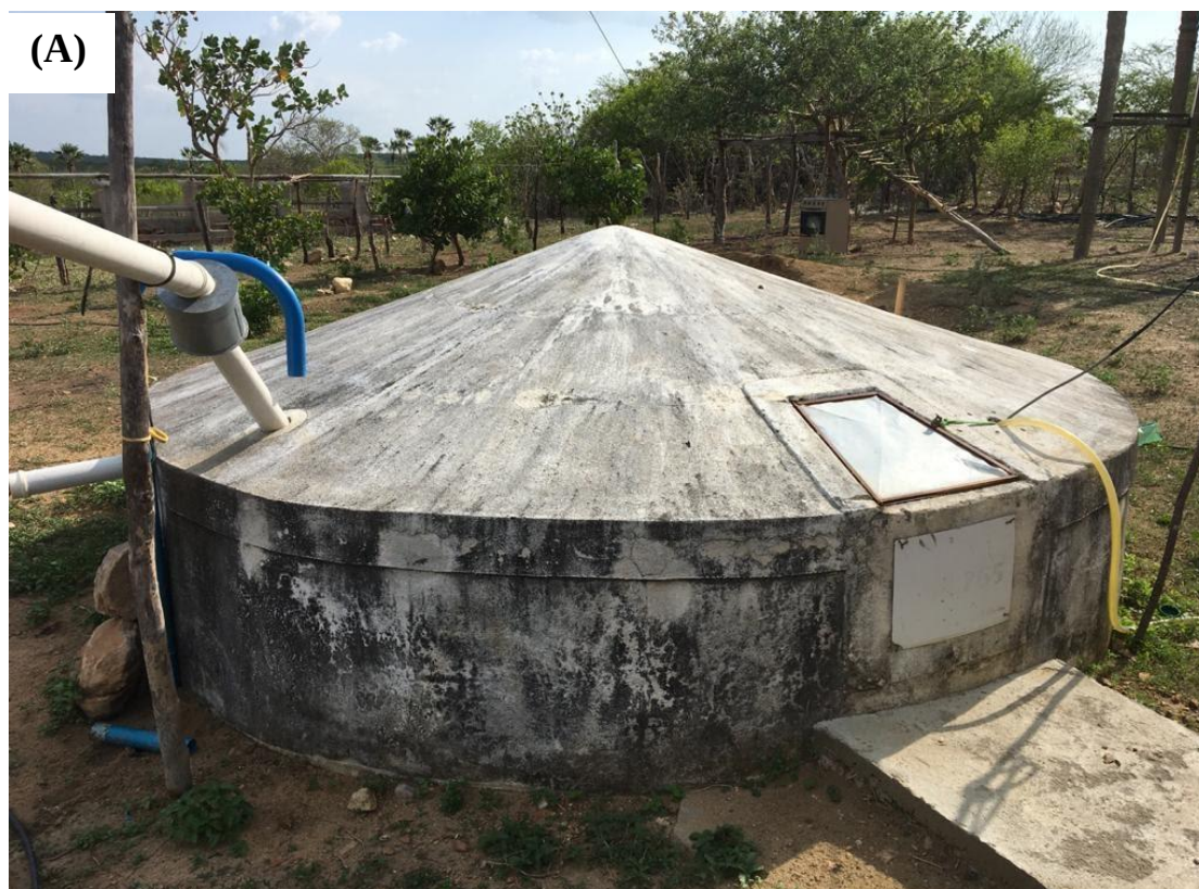
Figura 5 - Vista frontal da cisterna: cisterna com capacidade de 16 mil litros (A); localização da cisterna próxima a moradia (B).
