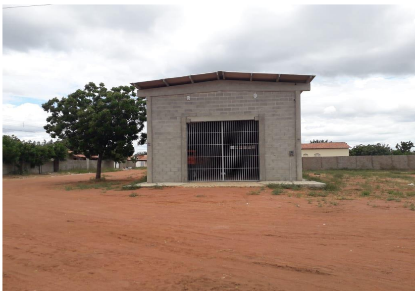
Assentamento Caqueira I. Galpão onde fica o trator da comunidade. Acervo da autora. 2019.
