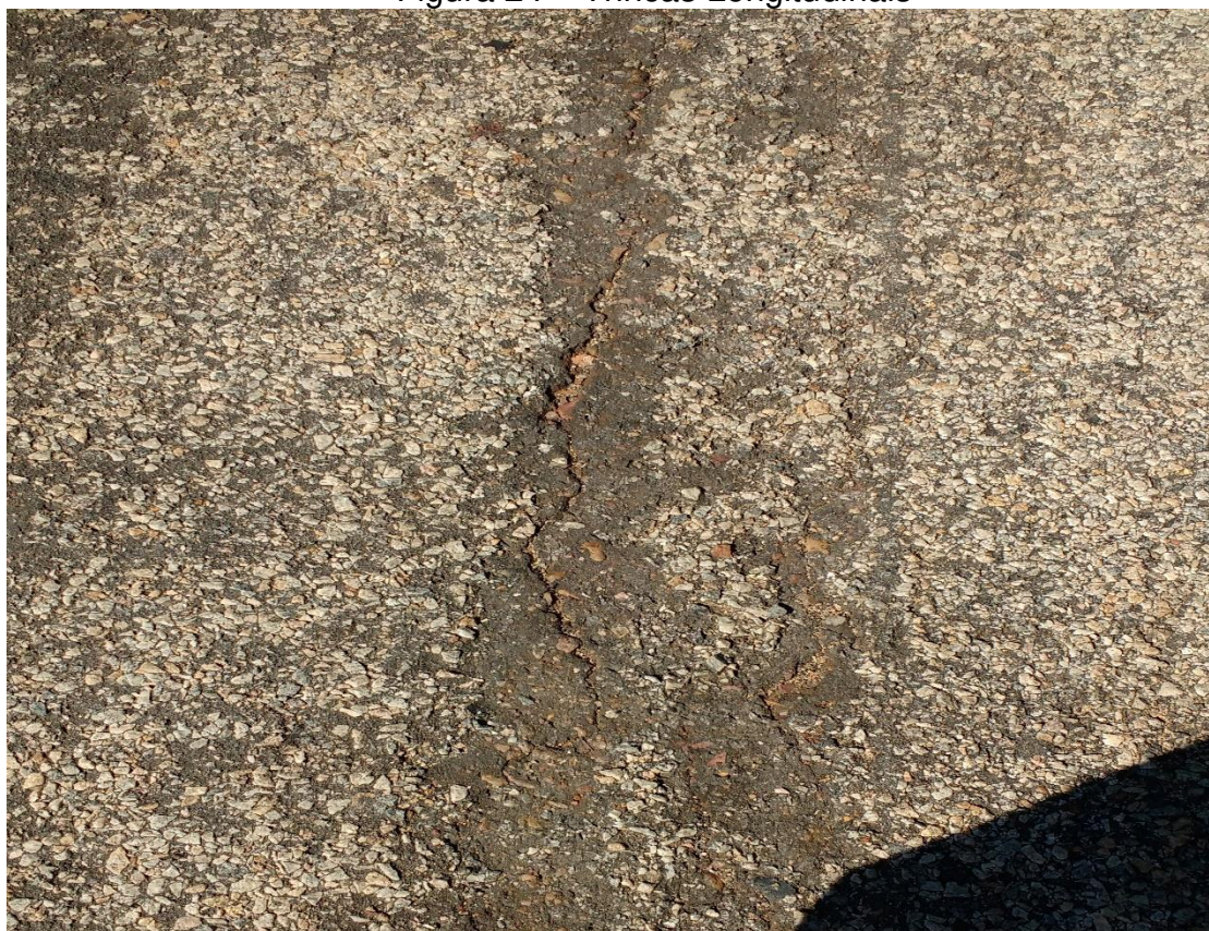
Figura 24 – Trincas Longitudinais
