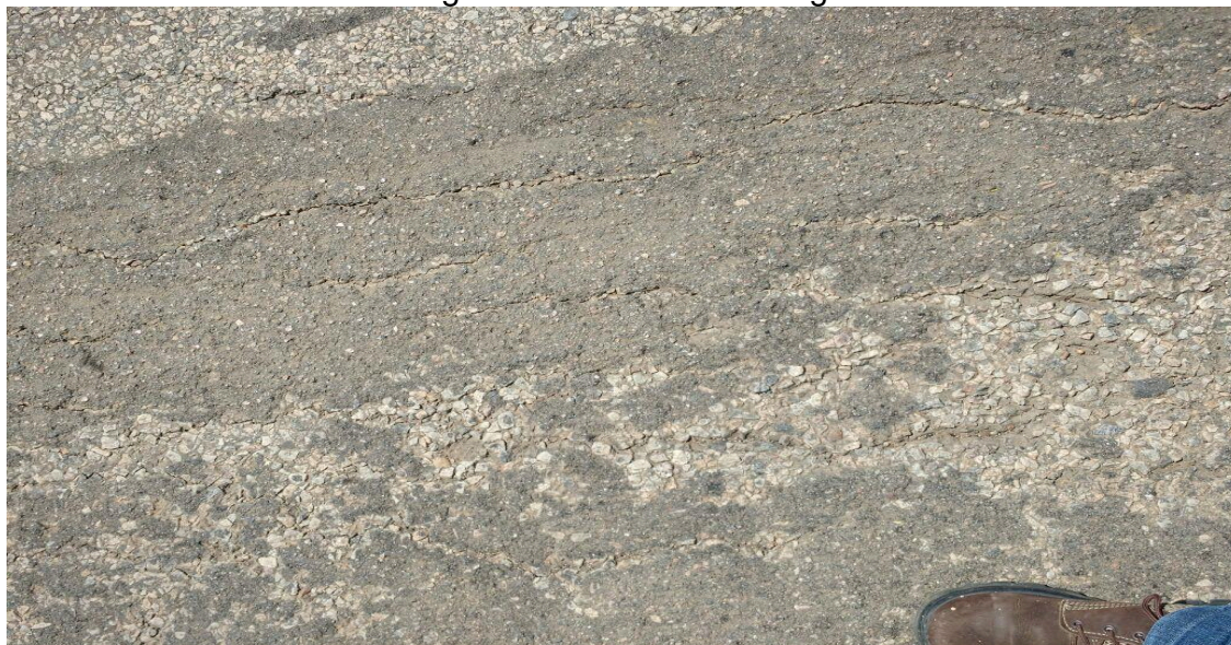
Figura 26 – Trincas Interligadas
