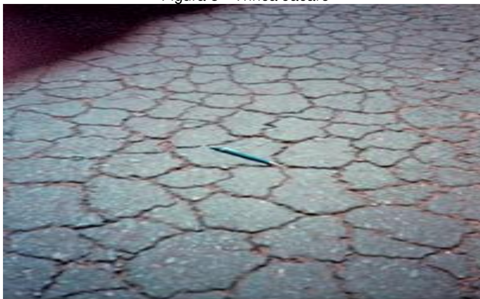
Figura 3 - Trinca Jacaré
