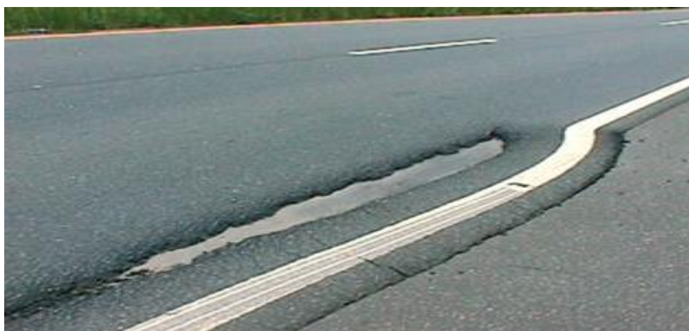
Figura 9- Escorregamento do revestimento
