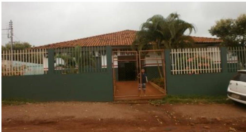
Figura 2. Entrada principal do CME Gentila Susin Muraro.
