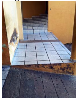
Imagem 11: Início do 3º bloco (1º andar).
