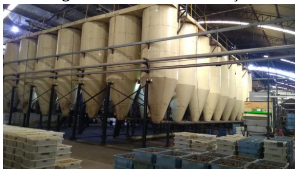
Figura 5 - Silos de umidificação
