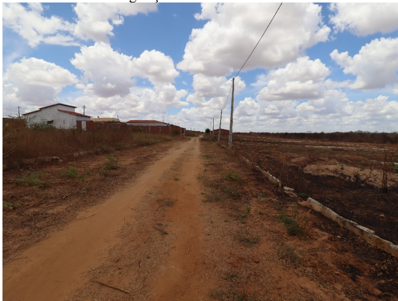
Figura 37: Parcela do loteamento sem pavimentação, iluminação e vegetação adentrando nos lotes.
