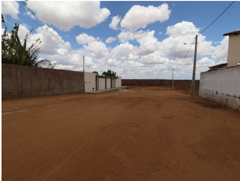
Figura 35: Infraestrutura da Rua Vereador Aécio Valentim.
