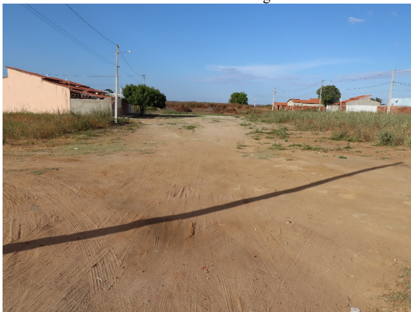
Figura 21: Trecho sem pavimentação da Rua João Batista Gurgel.
