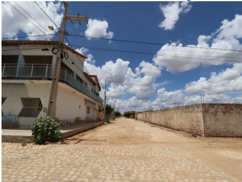
Figura 34: Pavimento da Rua José Gurgel.
