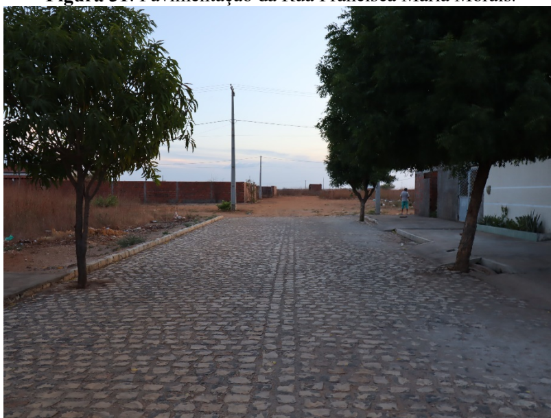
Figura 31: Pavimentação da Rua Francisca Maria Morais.
