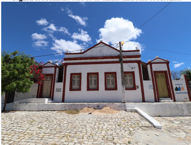
Figura 09: Primeira casa de alvenaria em Pedra de Abelhas.
