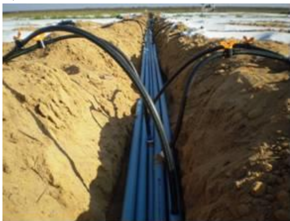
Figura 4. Linha de derivação com tubulações telescópicas em PVC de 32 e 25 mm com conectivos para linhas laterais (A); linhas laterais com tubos gotejadores (B)
