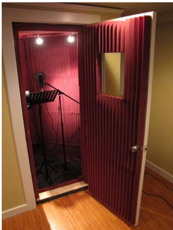
Figura 01 – Closet adaptado a uma cabine acústica
