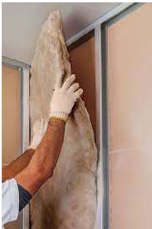
Figura 07 - Lã de vidro sendo posicionada para isolamento acústico
