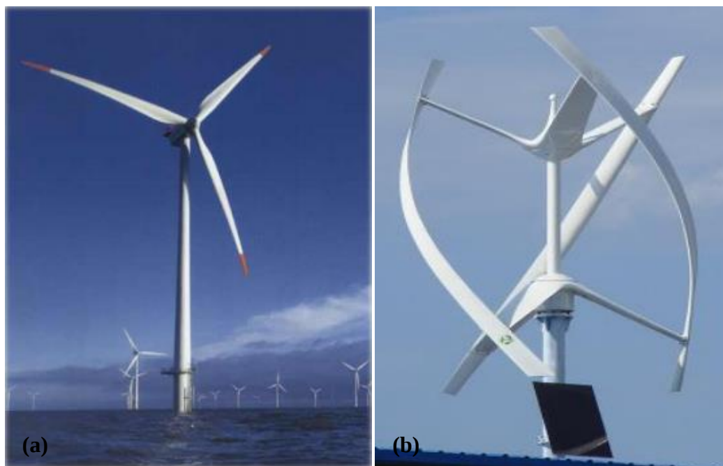
Figura 7 - Turbinas eólicas de eixo horizontal (a) e vertical (b) .
