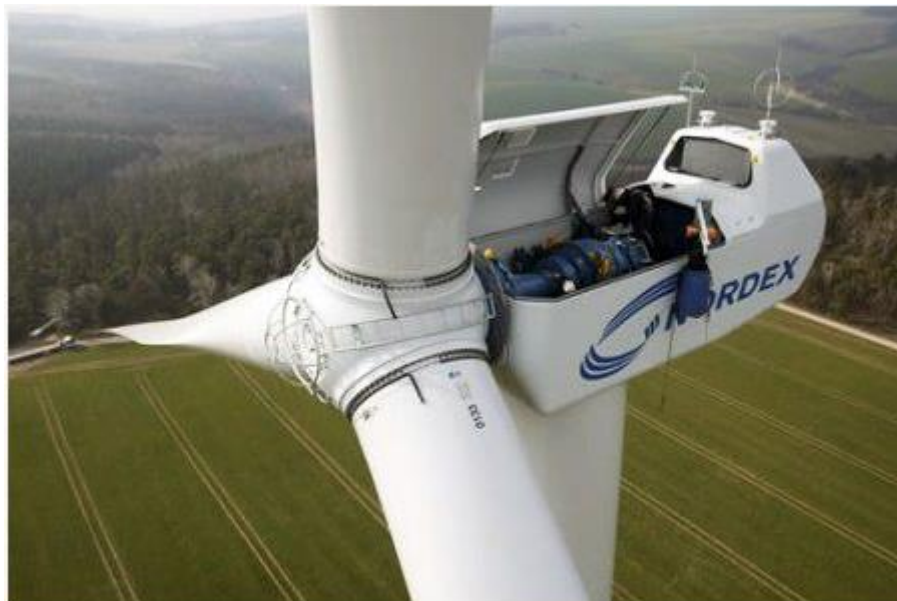
Figura 14 – Nacele de um aerogerador.
