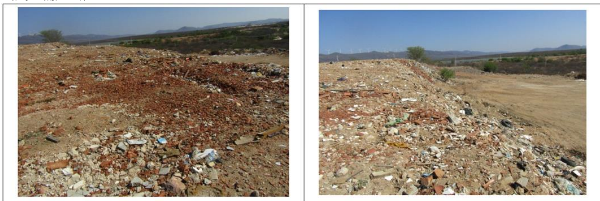
Figura 18 - Aterro controlado com cobertura de camadas de material sobre os rejeitos em Parelhas/RN.
