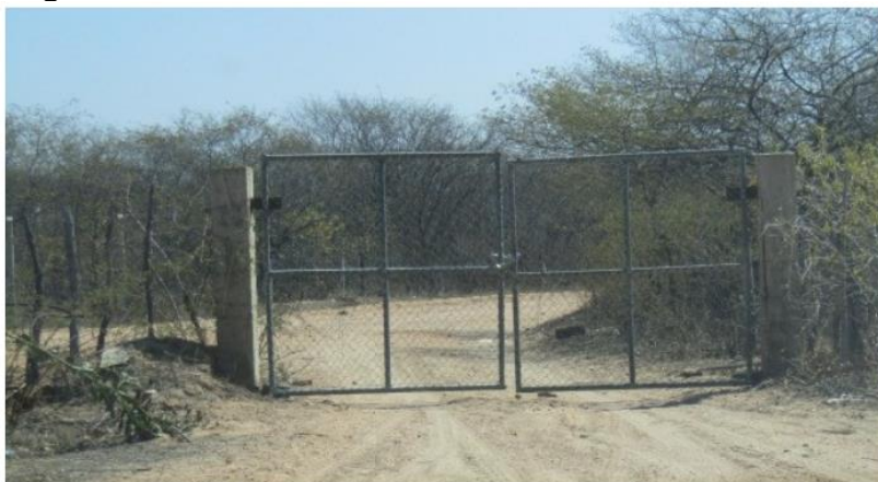
Figura 4 - Portão de Acesso ao aterro controlado de Acari/RN.
