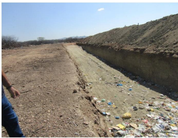
Figura 5 - Aterro controlado com cobertura de camadas de material sobre os rejeitos em Acari/RN.
