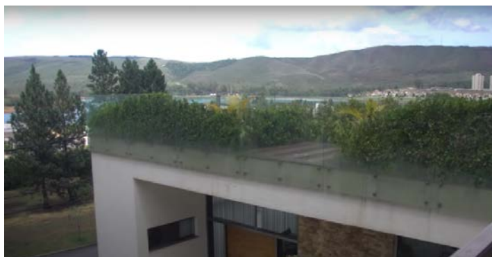
Figura 17: Telhado verde semi-intensivo
