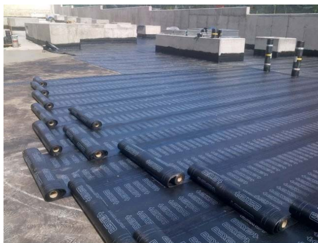
Figura 9: Camada de manta asfáltica.
