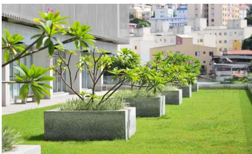
Figura 3: Telhado verde moderno
