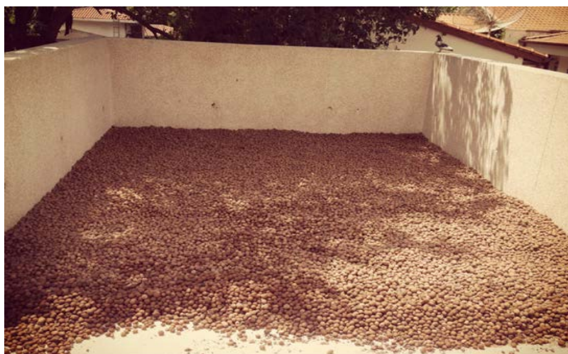
Figura 11: Camada drenante de argila expandida.
