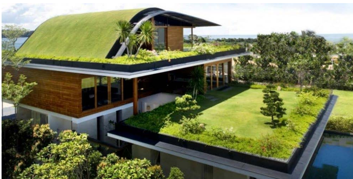
Figura 1: Telhado verde Singapura
