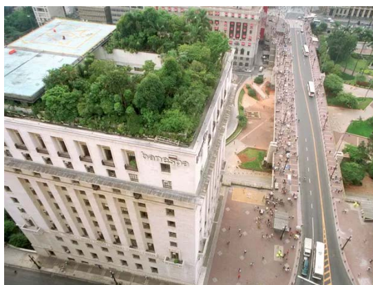
Figura 18: telhado verde intensivo
