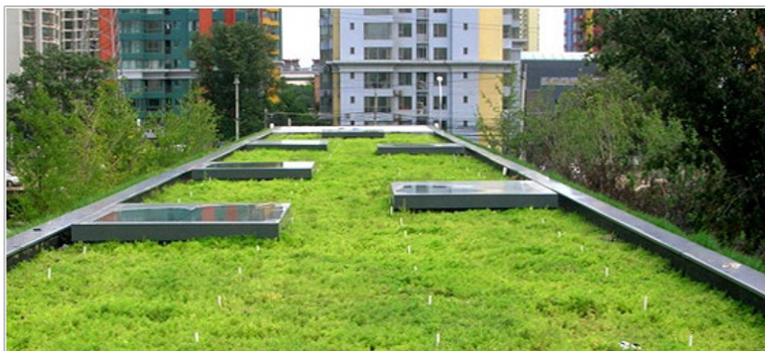
Figura 16: Telhado verde extensivo
