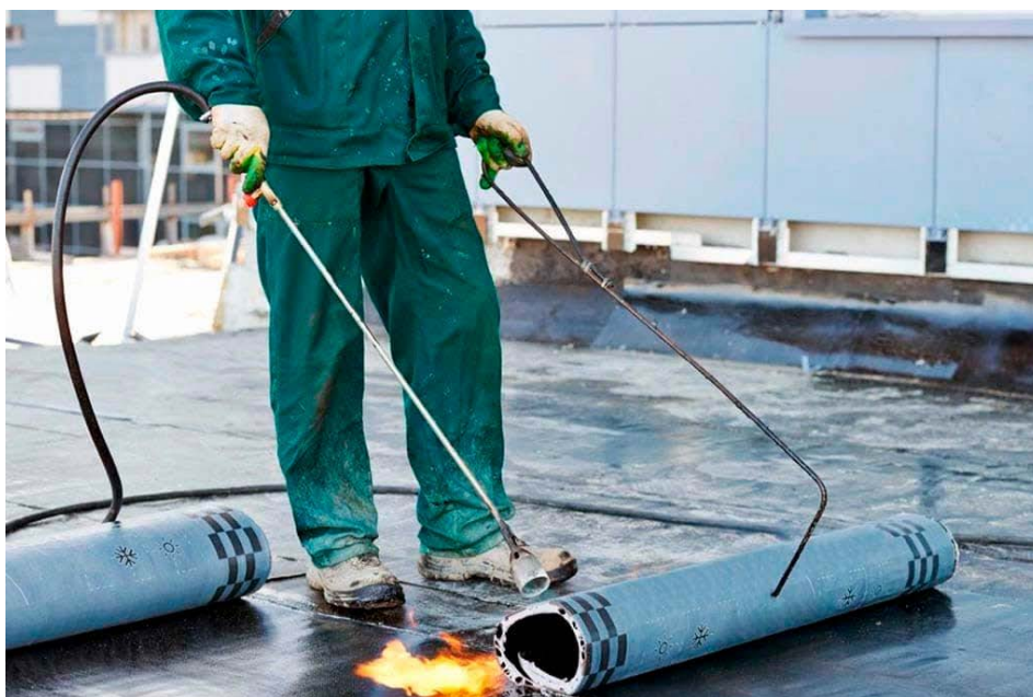
Figura 10: Aplicação da manta asfáltica
