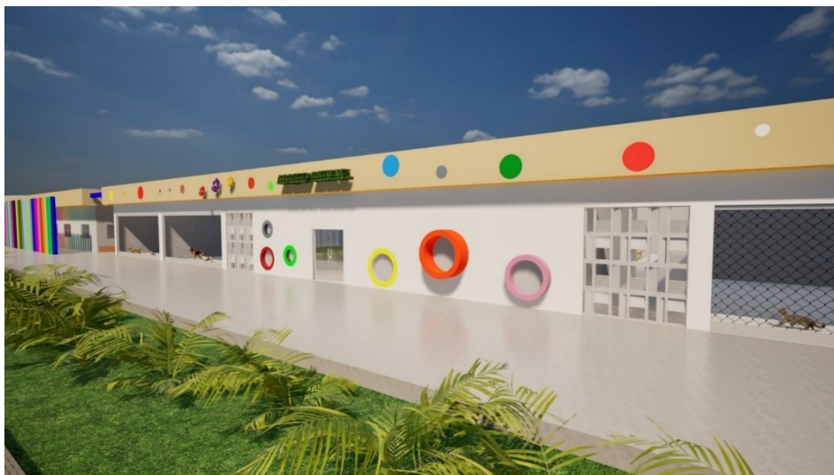
Figura 59 - Fachada frontal abrigo animal
