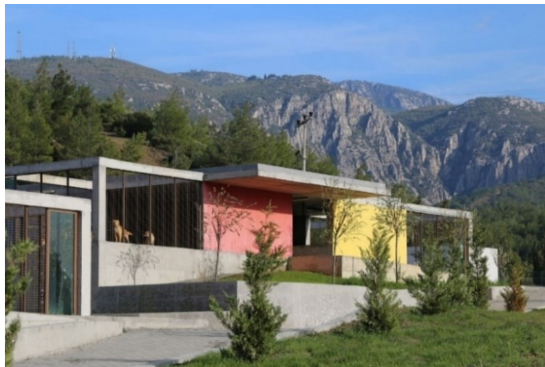
Figura 5 - Fachada do Centro Social Veterinário Pako Street
