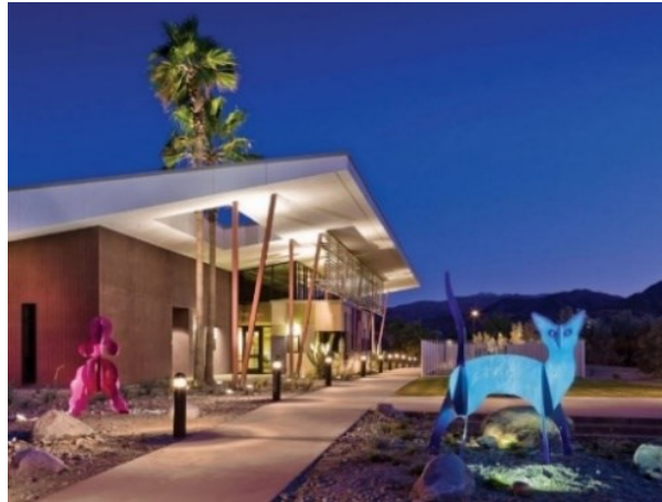
Figuras 18 - Fachada do edifício
