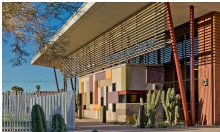
Figuras 17 - Fachada do edifício
