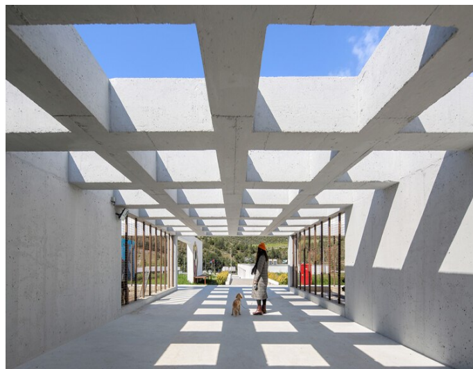
Figura 7 - Area interna do abrigo
