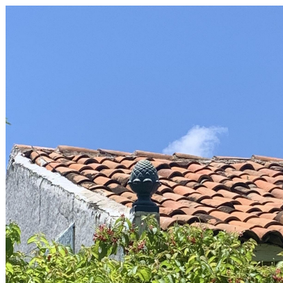
Figura 6: Cobertura original com pináculo decorativo
