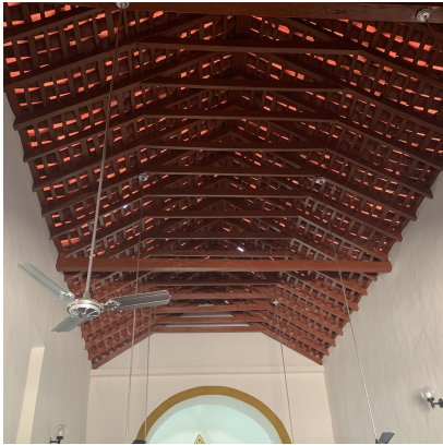
Figura 5: Cobertura da Capela
