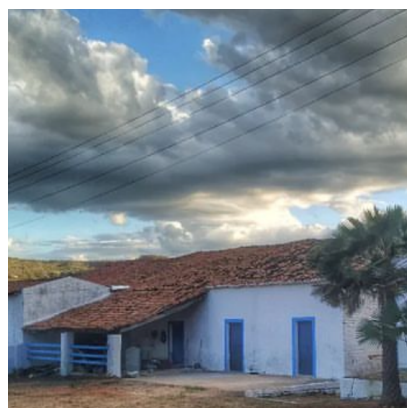
Figura 8: Depósitos, engenho e alambique na lateral da edificação
