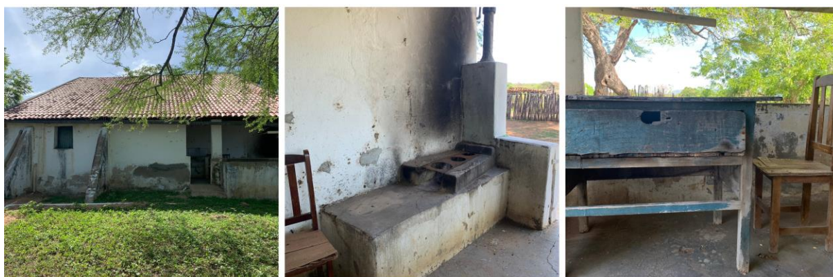
Figura 25 - Elementos encontrados na fachada posterior.
