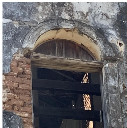
Figura 6: Detalhes dos vãos das esquadrias
