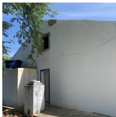
Figura 8: Reparos feitos no vão da esquadria do sótão e no telhado
