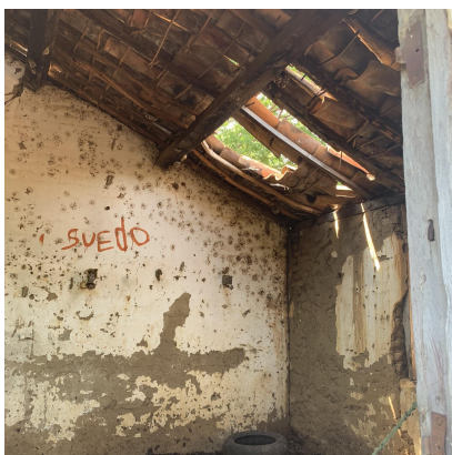
Figura 5: Cobertura original com algumas telhas faltantes
