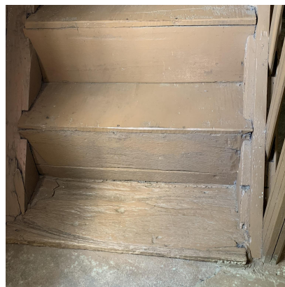
Figura 4: Piso original da escada em contraste com os pisos modificados
