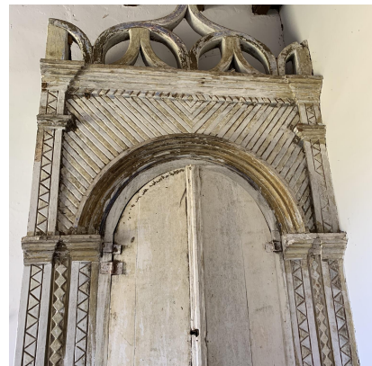
Figura 8: Oratório de madeira original
