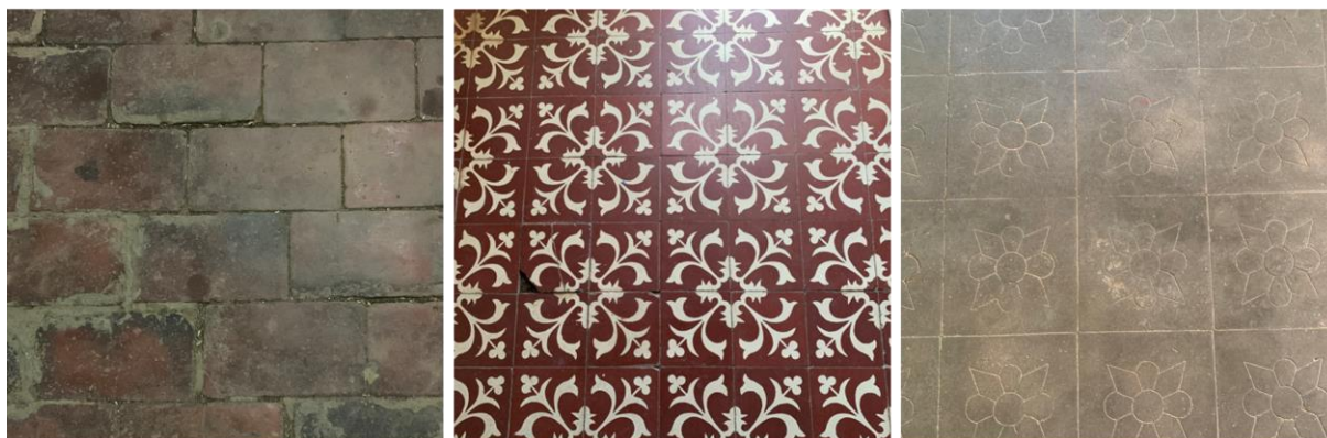
Figura 55 - Exemplos de pisos encontrados nas edificações.
