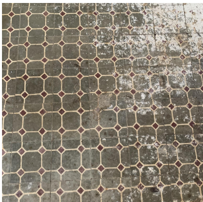
Figura 3: Piso de ladrilho hidráulico (sala térrea)
