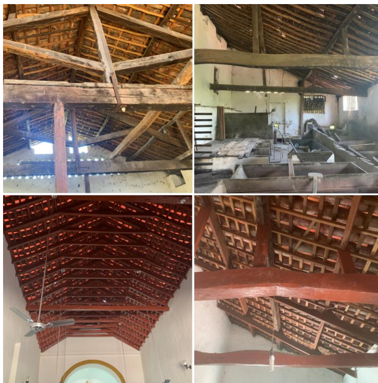
Figura 53 - Sistemas estruturais dos telhados
