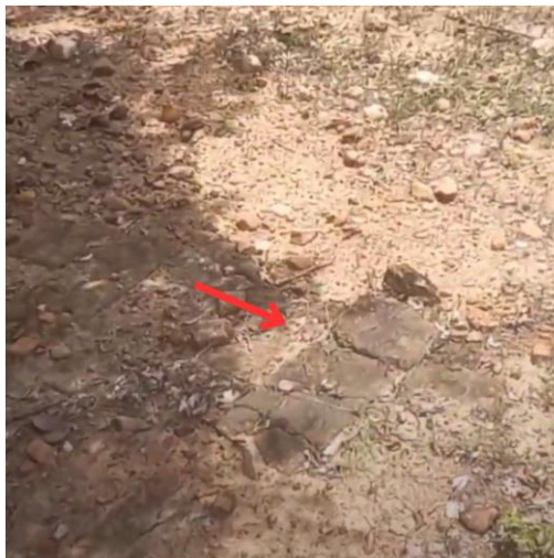
Figura 35 - Vestígios da antiga edificação em taipa.
