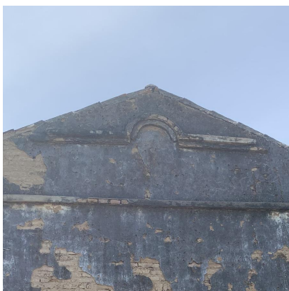
Figura 7: Detalhes da fachada frontal da edificação lateral
