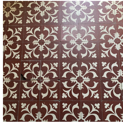
Figura 4: Piso de ladrilho hidráulico
