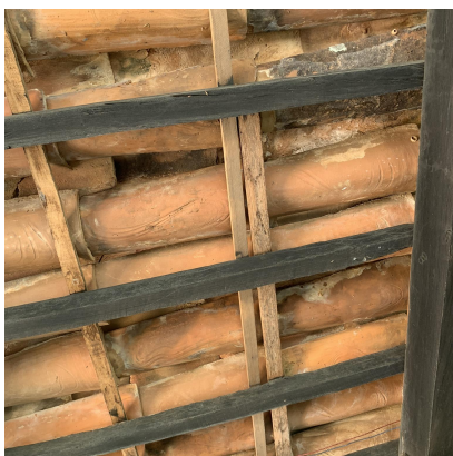
Figura 5: Telhas originais com madeiramento modificado (alpendre)
