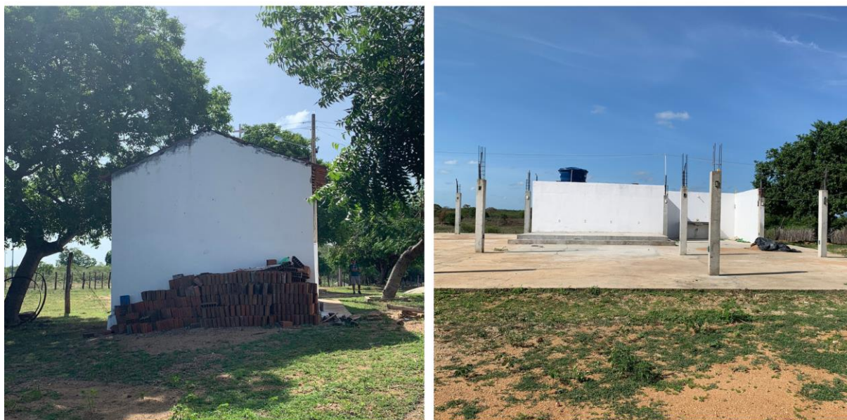
Figura 23 - Materiais de construção e obra inacabada.
