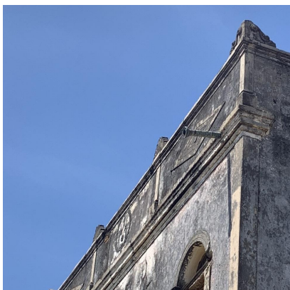
Figura 9: Elementos decorativos na platibanda
