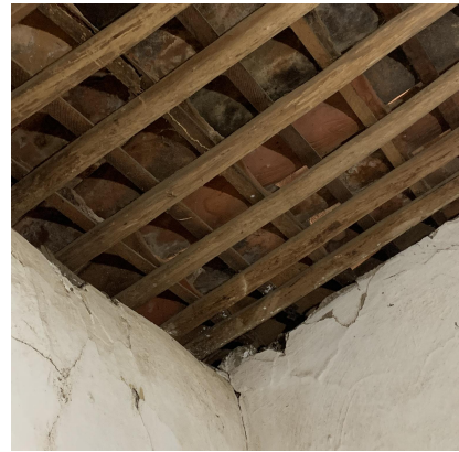
Figura 6: Cobertura com telhas originais e algumas partes do madeiramento modificados
