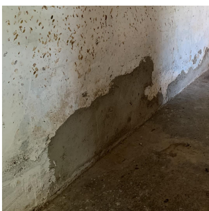
Figura 5: Reparos pontuais realizados na alvenaria
