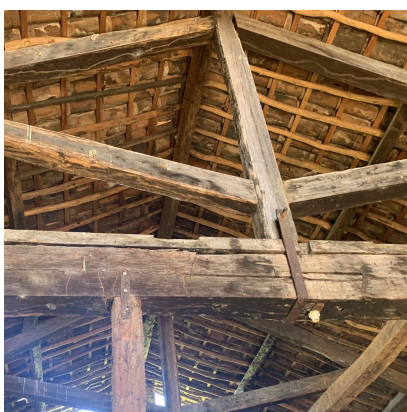
Figura 7: Cobertura original (Engenho)
