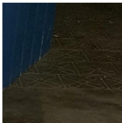
Figura 4: Piso original de cimento bordado
