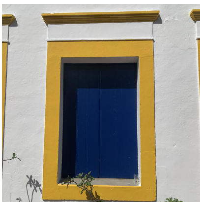
Figura 5: Detalhes nos vãos das esquadrias
