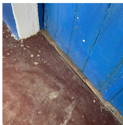
Figura 6: Piso do alpendre de cimento queimado com soleira de madeira
