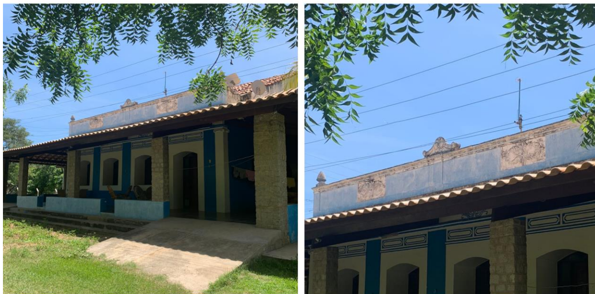
Figura 38 - Fachada da Fazenda Curralinho.
