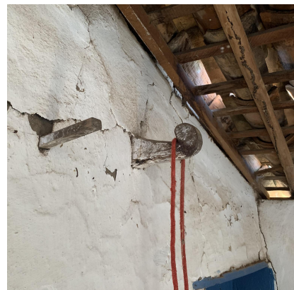
Figura 8: Armadores originais remanescentes
