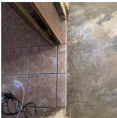
Figura 5: Piso de cerâmica (à esquerda) em contraste com o piso de cimento queimado original (à direita)
