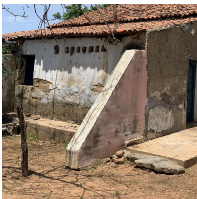
Figura 7: Presença de contraforte na fachada posterior
