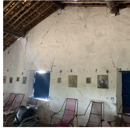
Figura 4: Interior da edificação
