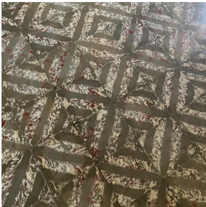
Figura 5: Piso de ladrilho hidráulico
