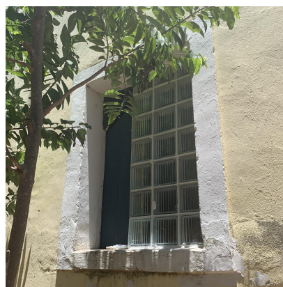
Figura 6: Inserção de blocos de vidro nas esquadrias em andamento
