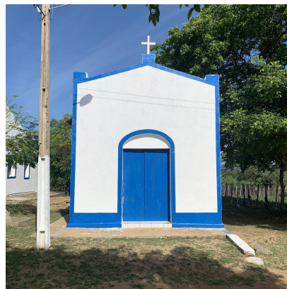
Figura 4: Capela construída na lateral da edificação
