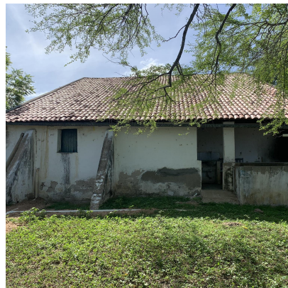
Figura 10: Presença de contrafortes na fachada posterior
