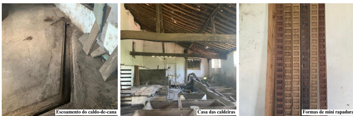
Figura 11 - Elementos encontrados na casa das caldeiras.
