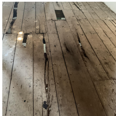
Figura 4: Piso de madeira (sótão)
