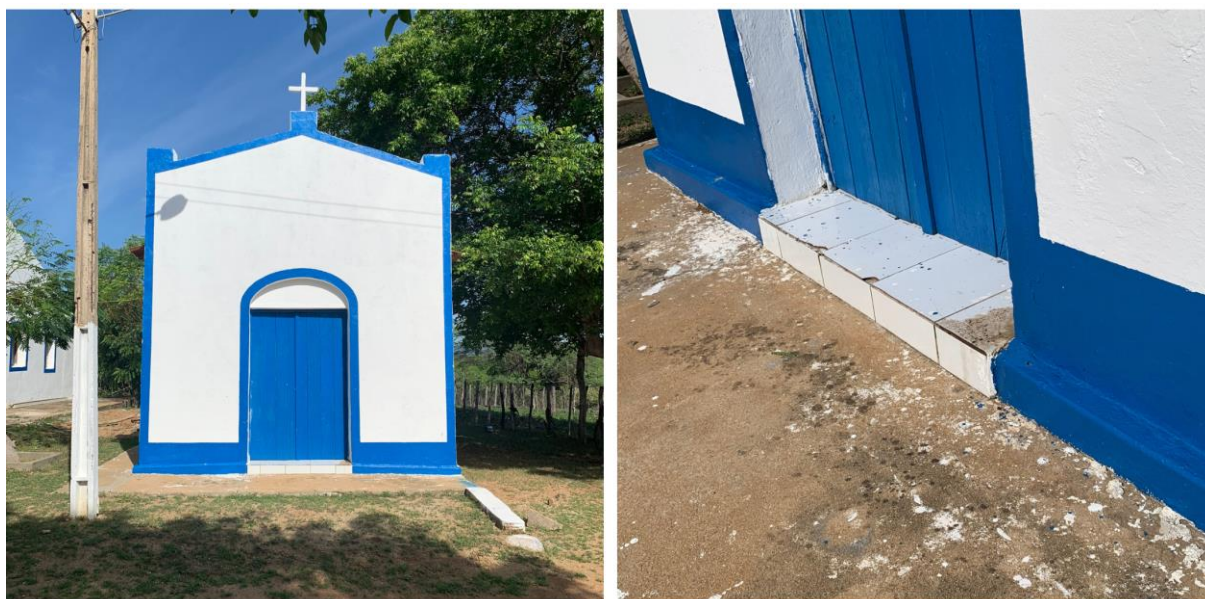
Figura 24 - Capela encontrada no Casarão Bonfim de Cima.
