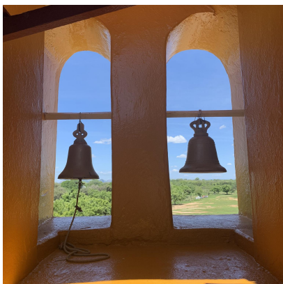
Figura 9: Paredes construídas com mais de 50cm de espessura
