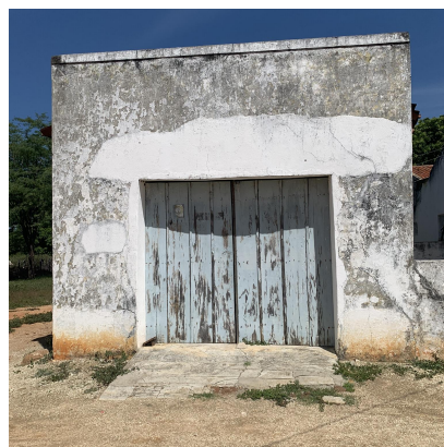
Figura 8: Depósito à lateral da edificação
