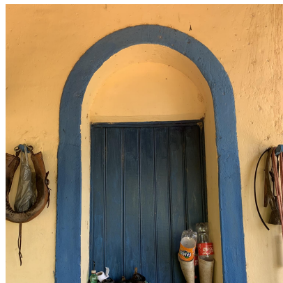
Figura 4: Detalhes em arco no vão das esquadrias frontais
