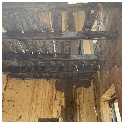
Figura 8: Piso do primeiro pavimento
