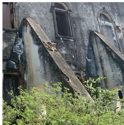
Figura 4: Contrafortes presentes nas fachadas laterais da edificação
