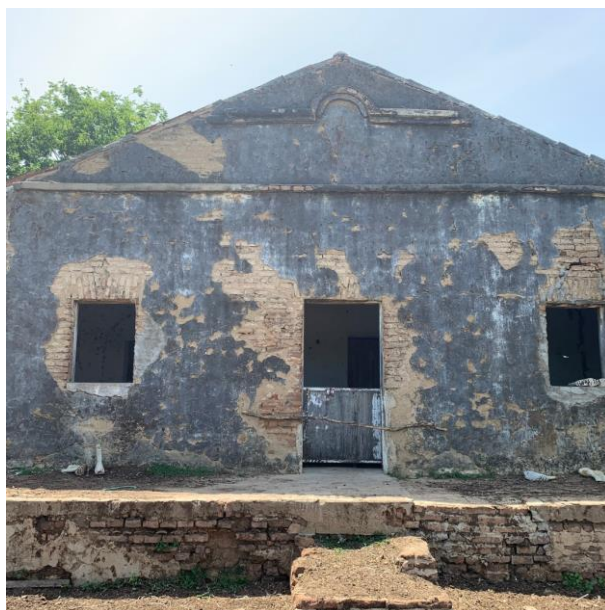
Figura 40 - Fachada com detalhe.
