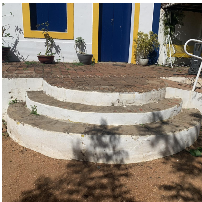
Figura 3: Escadaria da edificação principal em formato “meia-lua”
