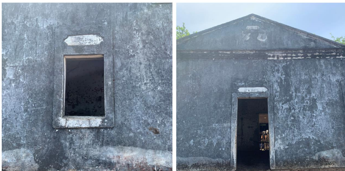
Figura 39 - Detalhes na fachada do casarão do Sítio São Gonçalo.
