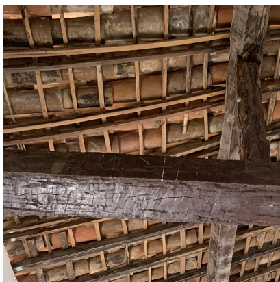
Figura 7: Telhas originais com alguns madeiramentos modificados
