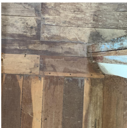
Figura 7: Piso de madeira original (em cima) em contraste com piso de madeira modificado (embaixo)
