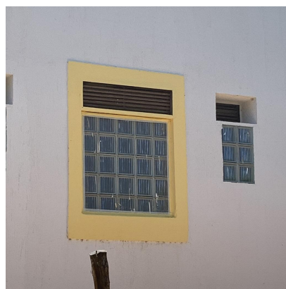
Figura 8: Inserção de blocos de vidros nas esquadrias finalizado
