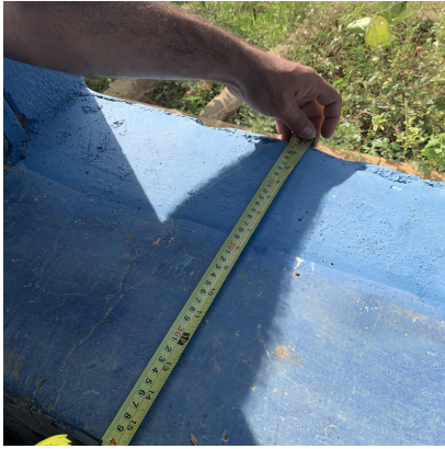
Figura 3: Paredes com 40cm de espessura
