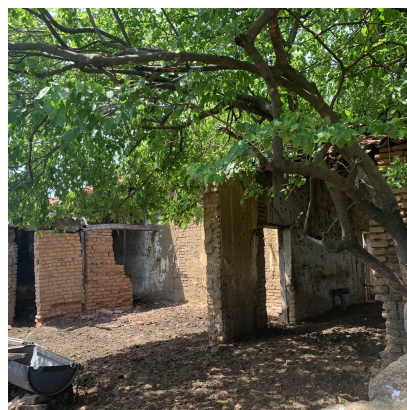
Figura 8: Lateral da edificação
