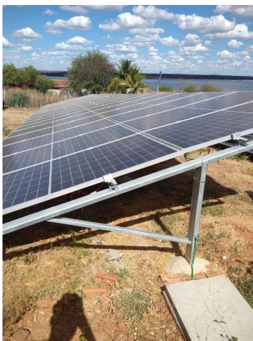
Figura 25 - Estrutura de solo
