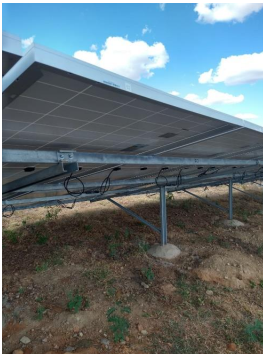
Figura 26 - Estrutura de solo
