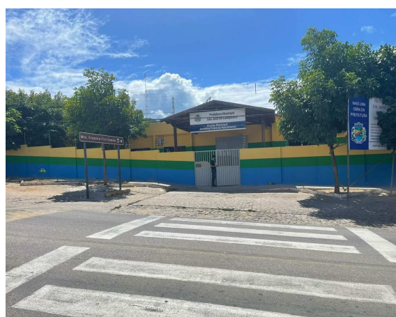
FIGURA 10: Calçada, rampa de acesso externo da Escola Municipal Jardimelina.
