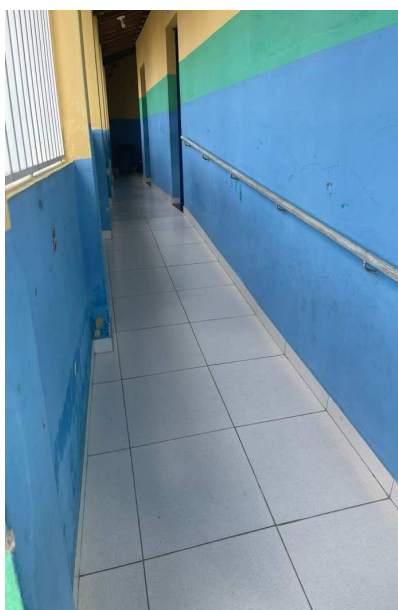
FIGURA 4: Rampa Interna da Escola Creche Mundo Feliz.
