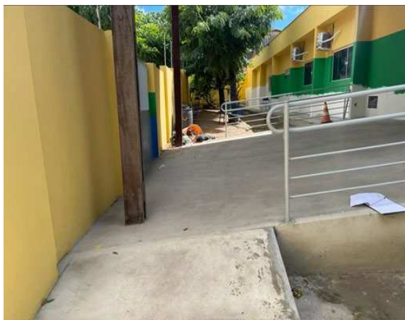
FIGURA 11: Rampa de acesso externo da Escola Municipal Jardelina.
