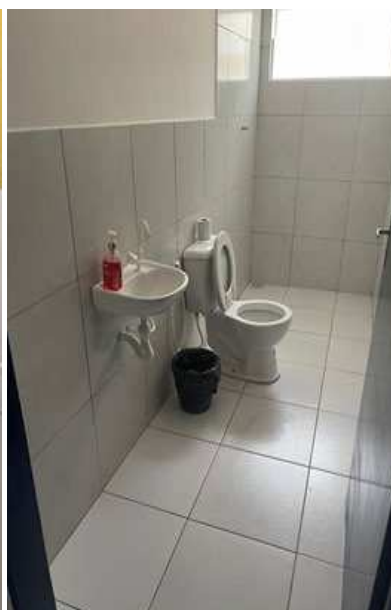
FIGURA 16: vaso não permite ter área de transferência da Escola Municipal Jardelina
