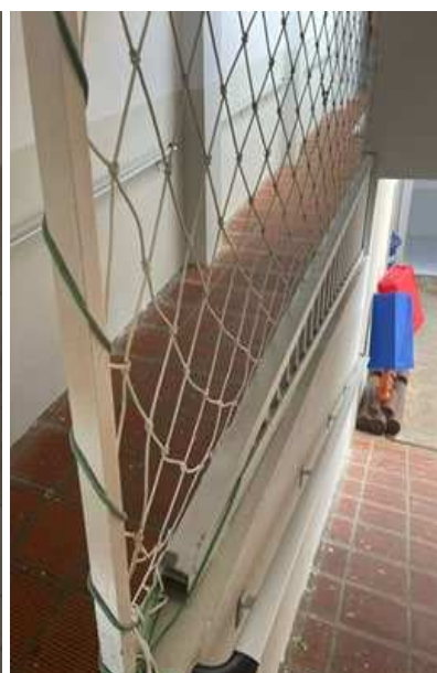
FIGURA 6: Rampa Interna da Escola Creche Municipal São José.
