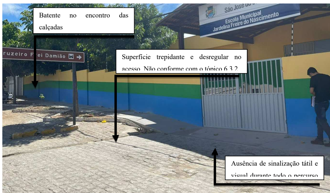
FIGURA 22: Entrada e estacionamento da Escola Municipal Jardelina Freire do Nascimento
