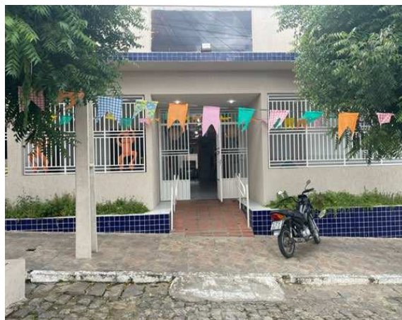
FIGURA 12: Calçada, rampa de acesso externo da Creche Municipal São José.
