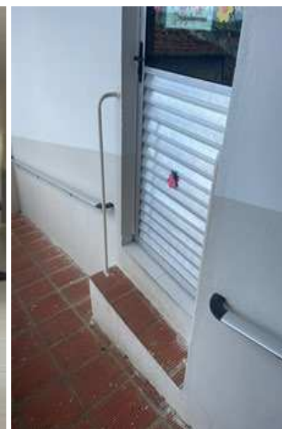
FIGURA 20: Batente que impede o uso da sala por PCD Escola Creche Mundo Feliz.
