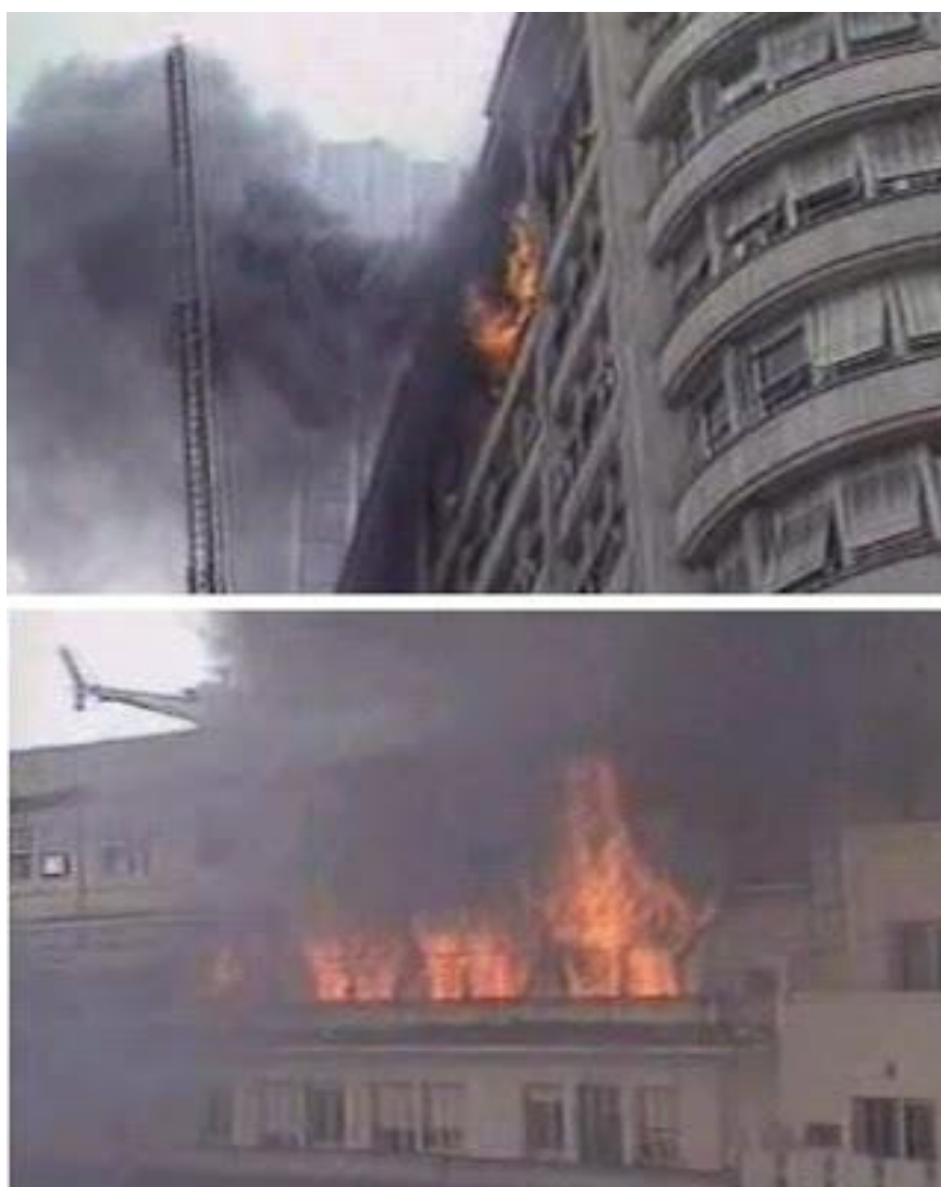
Figura 9: Incêndio no Edifício Andorinha
