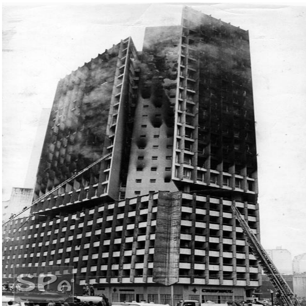
Figura 8: Edifício Joelma em chamas.
