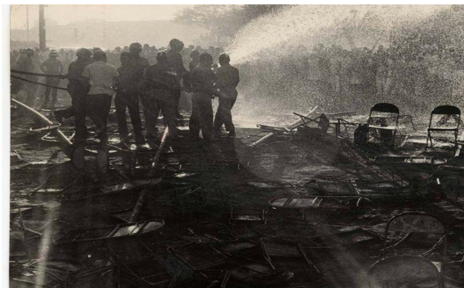
Figura 6: Destroços do circo após incêndio
