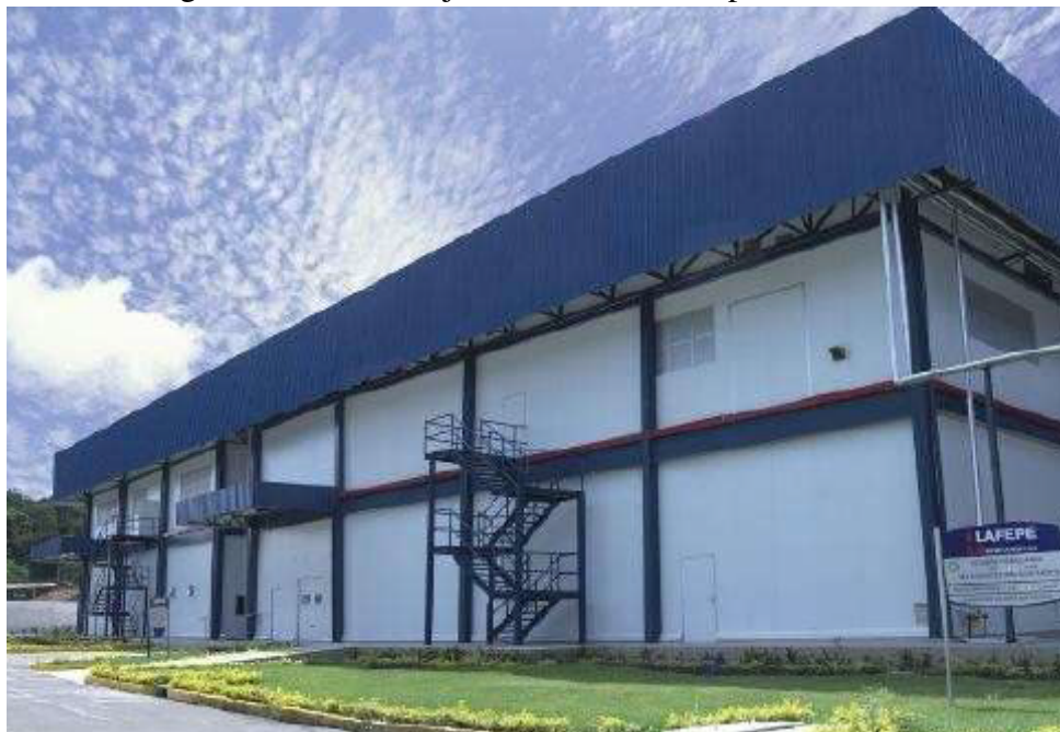
Figura 14 – Vista do jardim em frente ao prédio de sólidos
