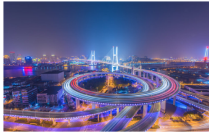
c. Ponte Nambu (China)
