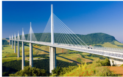
e. Millau Viaduct (França)
