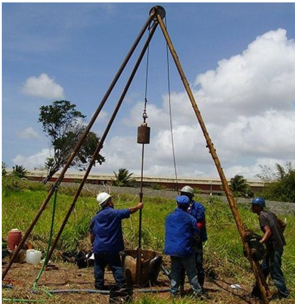
Figura 4 - Execução da sondagem
