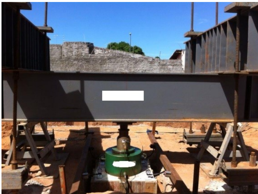
Figura 21 - Montagem da prova de carga
