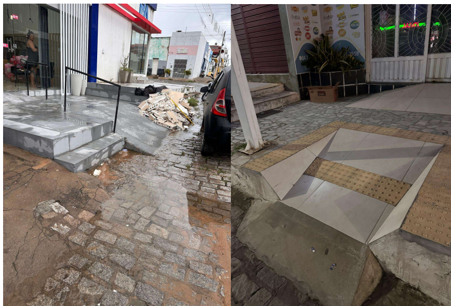
Figura 16 - Lotes comerciais com degraus e rampas inadequadas
