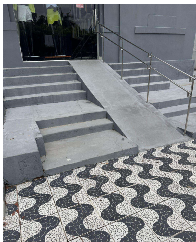
Figura 22 - Rampa de acesso a comércio.
