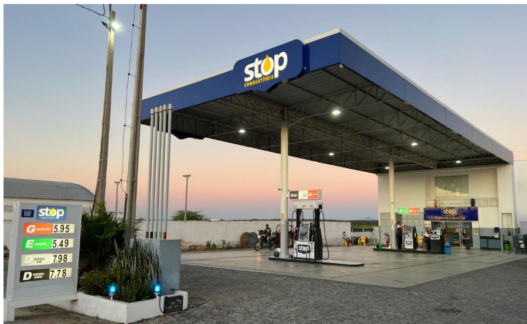
Figura 3 - Posto Stop Combustíveis
