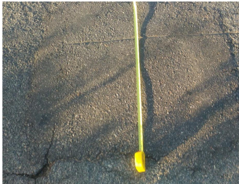
Figura 4.11- Remendo
