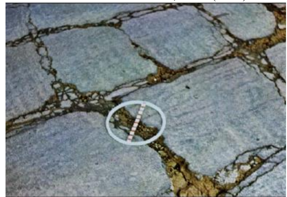
Figura 3.8- Trincamento Longitudinal, DNIT (2003) Figura 3.9- Trincamento em Blocos, DNIT(2003)
