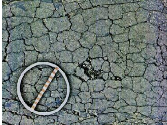
Figura 3.6- Trincamento por Fadiga, DNIT (2003) Figura 3.7- Trincamento transversal, DNIT(2003)
