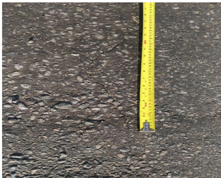
Figura 4.5- Trincamento Longitudinal
