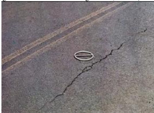
Figura 3.8- Trincamento Longitudinal, DNIT (2003) Figura 3.9- Trincamento em Blocos, DNIT(2003)
