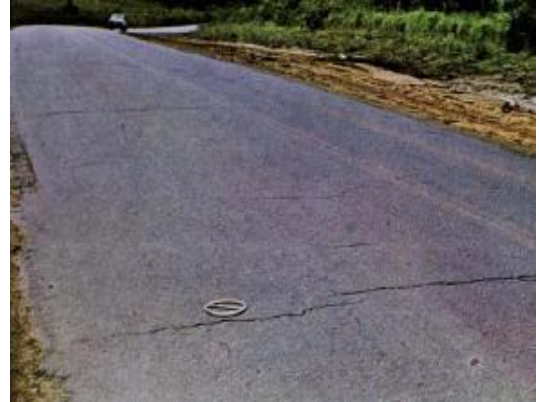
Figura 3.6- Trincamento por Fadiga, DNIT (2003) Figura 3.7- Trincamento transversal, DNIT(2003)
