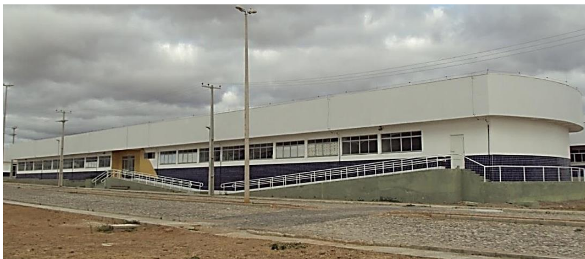
Figura 15 – Imagem externa do bloco de salas de professores I.
