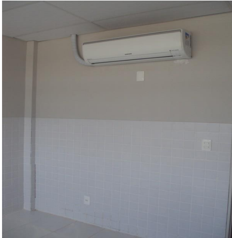
Figura 34 – Imagem dos pilares sobressaindo à parede na sala de professores.
