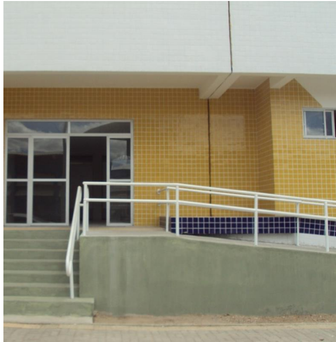
Figura 32 – Imagem da junta de dilatação do edifício.
