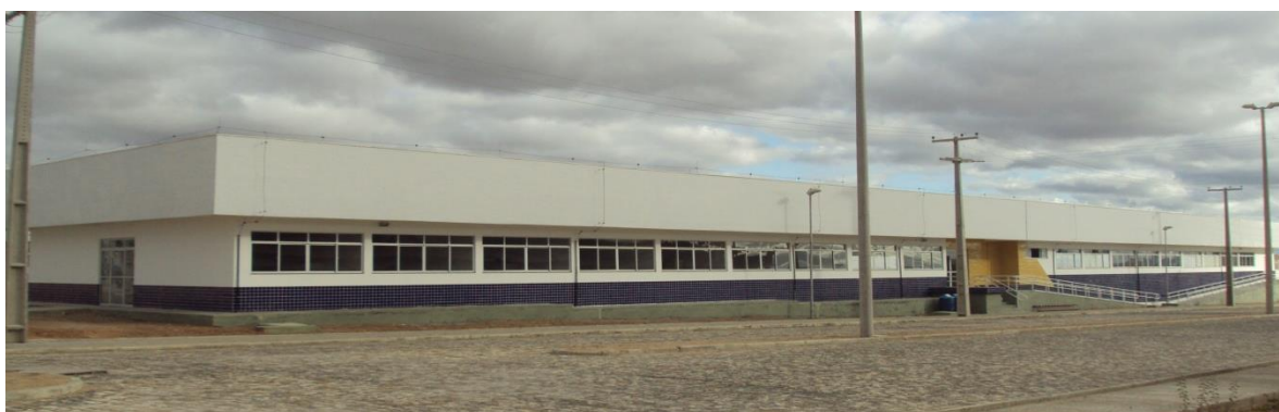
Figura 12 – Fachada frontal do bloco de salas de professores I.
