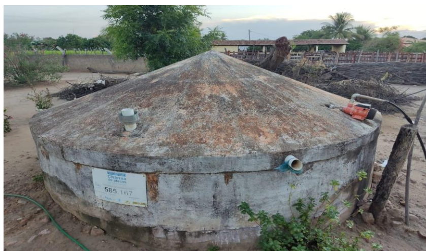
Figura 5: Cisterna localizada no município de Mauriti - CE
