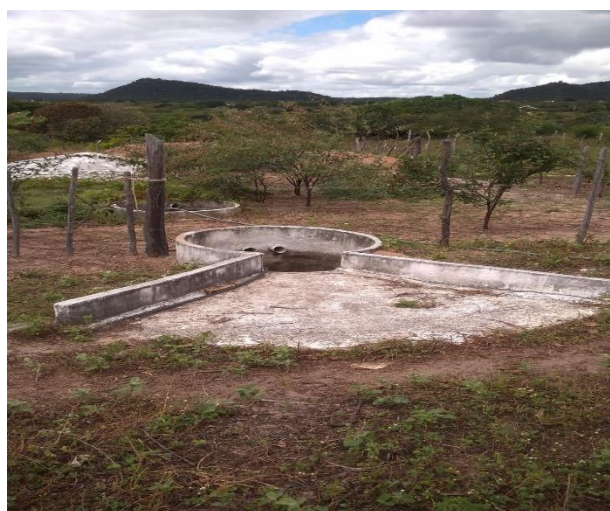
Figura 8: Cisterna de enxurrada localizada no município de Mauriti - CE
