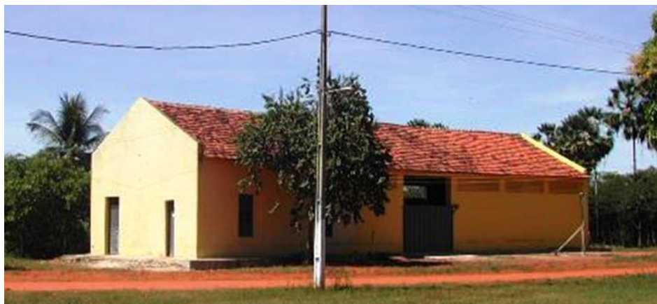
Figura 8. Galpão/Sala de processamento de cera e sala de mel
