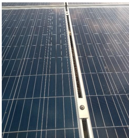
Figura 13. Conexão metálica entre as estruturas dos módulos. (Autoria Própria, 2019)
