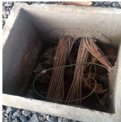
Figura 15. Caixa de aterramento e passagem. (Autoria Própria, 2019)
