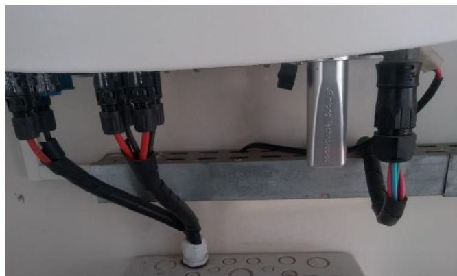
Figura 16. Circuitos de entrada e saída dos inversores. (Autoria Própria, 2019)
