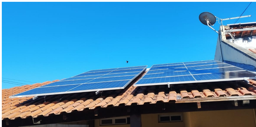
Figura 8. Sombreamento presente nos módulos fotovoltaicos. (Fonte: Autor).
