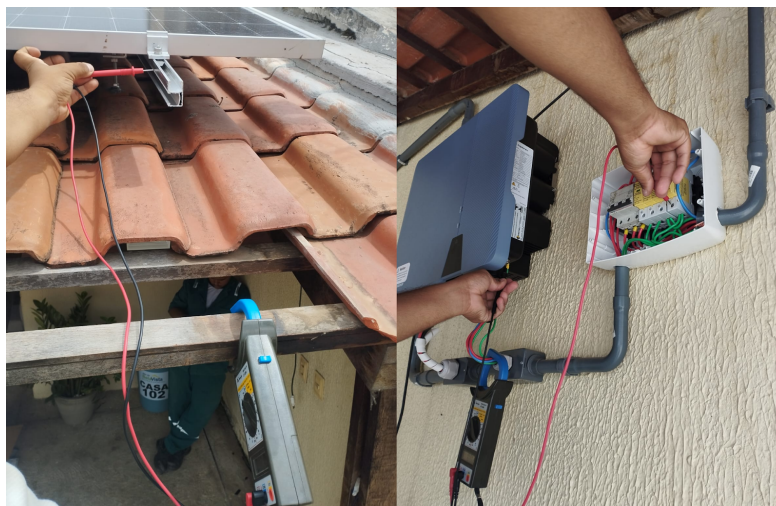
Figura 9. Ensaio de equipotencialização nos módulos fotovoltaicos e inversor. (Fonte: Autor).
