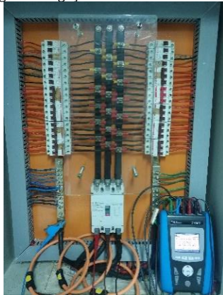
Figure 4. Ligação do analisador de energia
