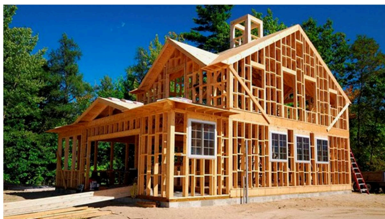
Figura 4: Exemplo de casa em Wood Frame.
