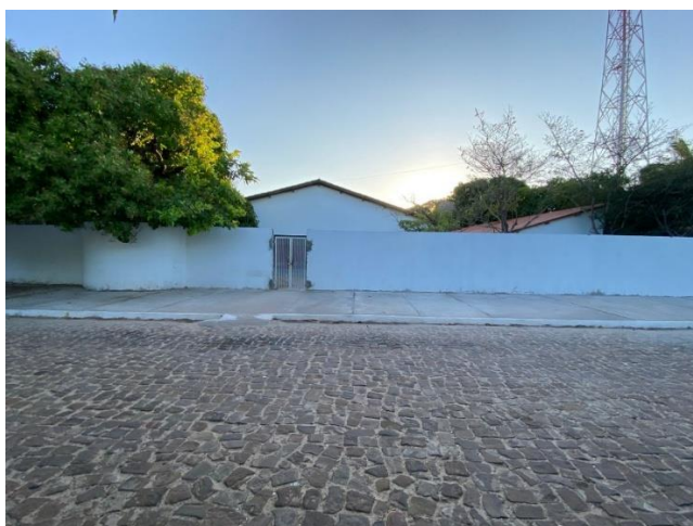
Figura 4 - Fachada da Escola 3 e 4
