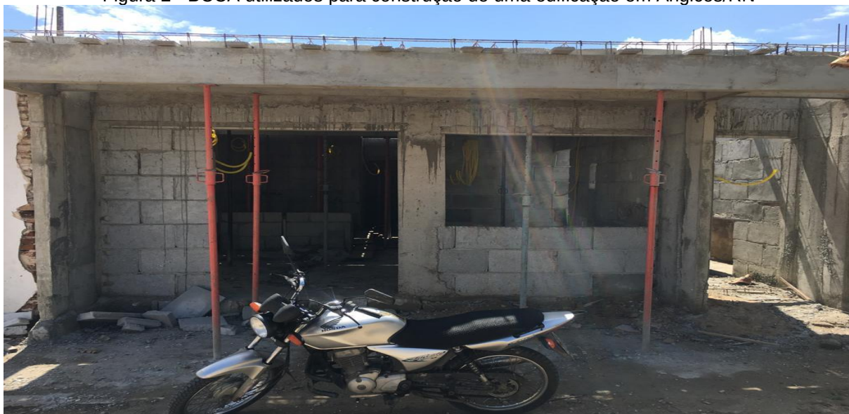
Figura 2 - BCCA utilizados para construção de uma edificação em Angicos/RN
