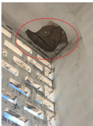
Figura 27 - Exposição do aço em laje.
