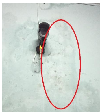
Figura 22 - Problema de umidade com manchas amareladas, em a) sala 01 e b) sala 02.
