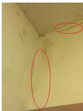
Figura 25 - Aberturas por falta de amarração, em a) porta de acesso a escada e b) porta de acesso a uma sala.
