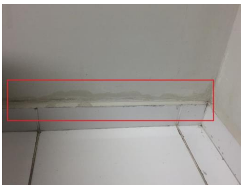
Figura 21 - Problema de umidade com mofo/bolor.
