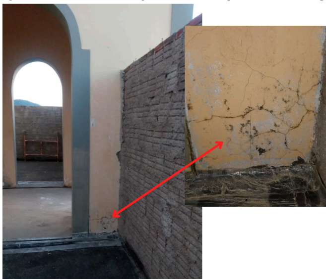
Figura 18 – Revestimento argamassado da esquerda, externa no primeiro pavimento.
