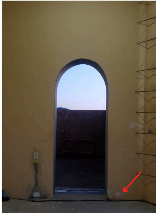
Figura 21 – Revestimento argamassado da direita, interna no primeiro pavimento.
