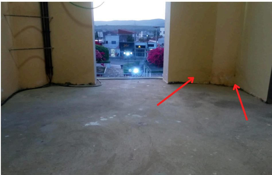
Figura 19 – Revestimento argamassado frontal, interna no primeiro pavimento.
